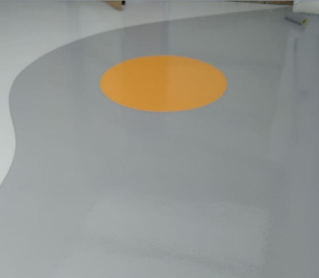
É um revestimento composto por resina de poliuretano alifático, bi componente, de acabamento brilhante, de baixa espessura, de aspecto casca de laranja ou antiderrapante.
